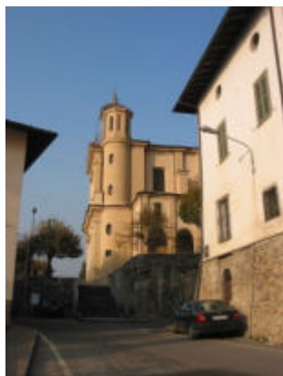
Facciata e scorcio dell'attuale chiesa parrocchiale di Santa Maria, di Vallalta (Bg)
