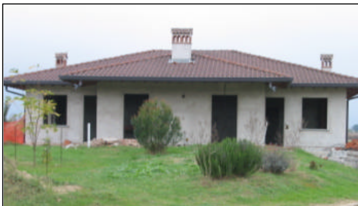
Abitazione in costruzione dei proprietari dell'Azienda Personeni Bergamo
