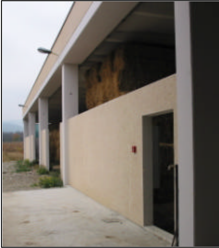
Parete prefabbricata Azienda Personeni Bg
