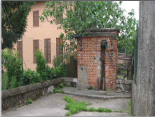
Pompa per l'acqua – Cascina Nuova Bergamo
