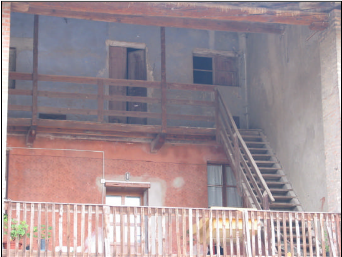
Foto 16 Scala e ballatoio in legno
