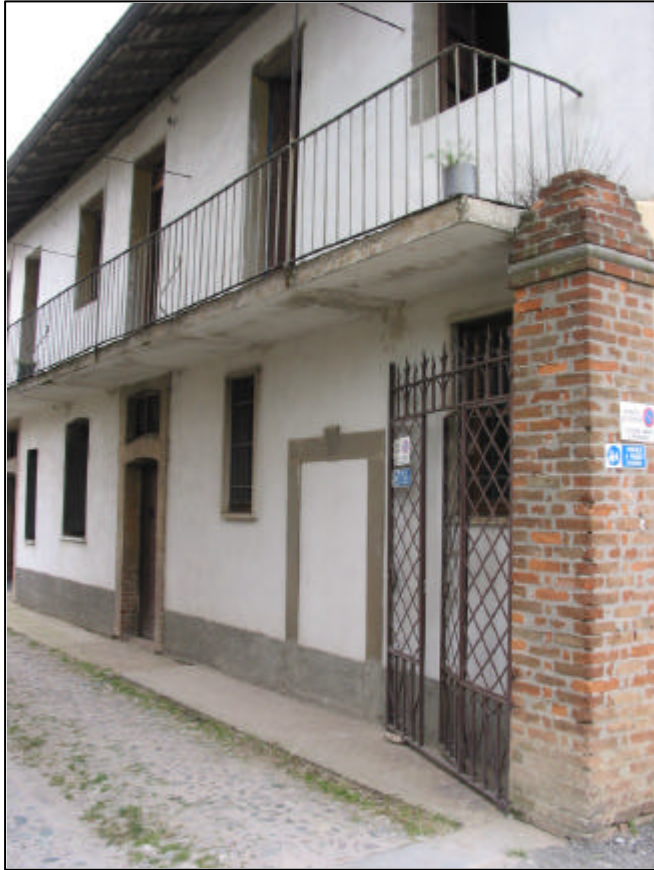
Foto07 Edificio in fase di ristrutturazione
