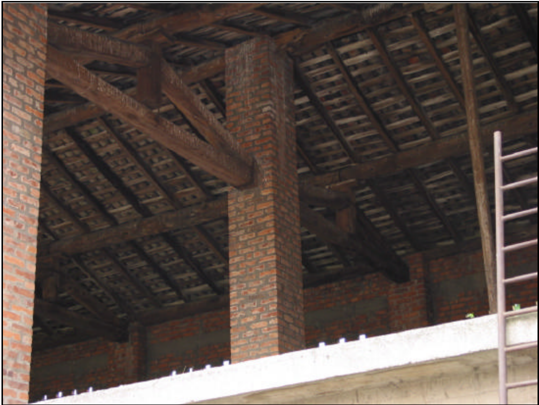
Foto 38 Capriata e copertura
