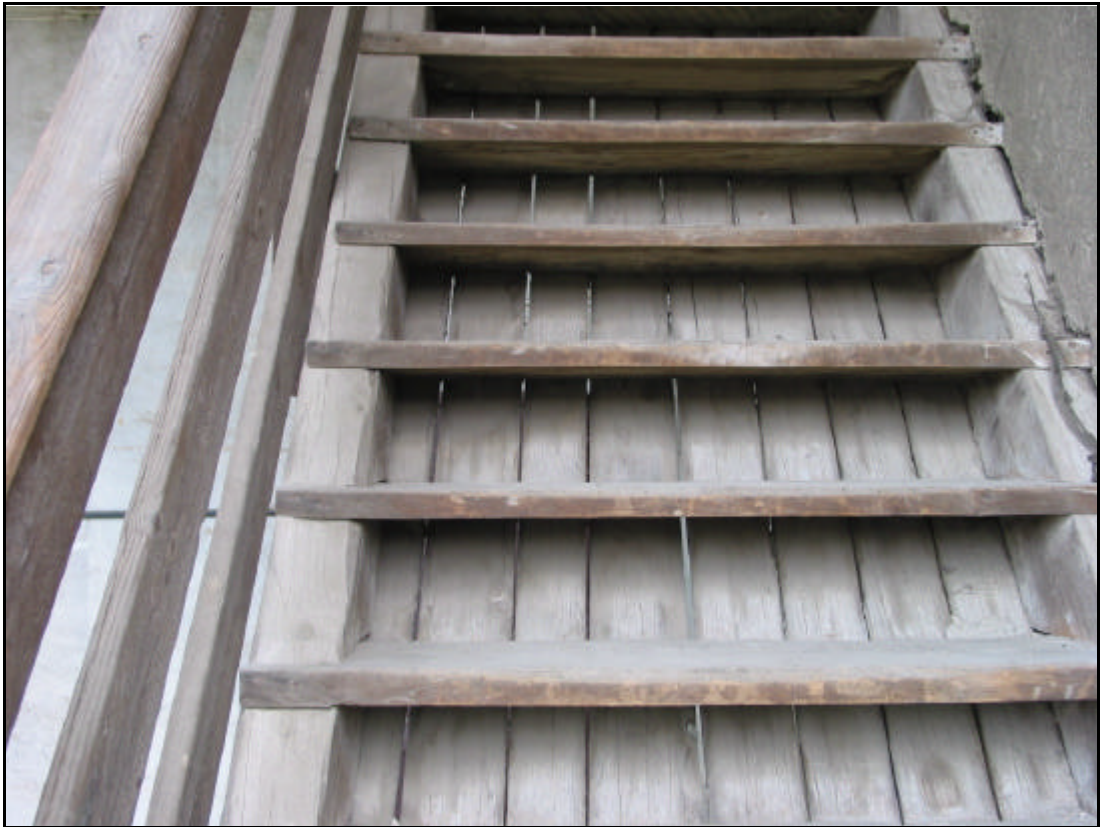
Foto 22 Particolare scala in legno
