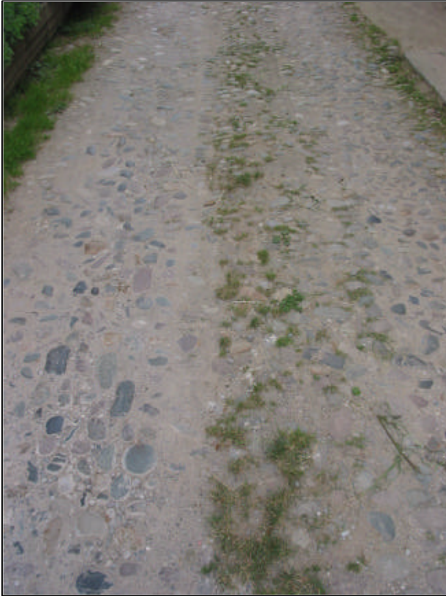
Foto 05 Struttura strada di accesso
