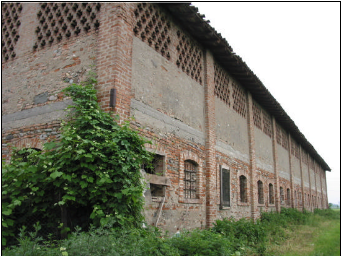
Foto 29 Sistema costruttivo della muratura in laterizio
