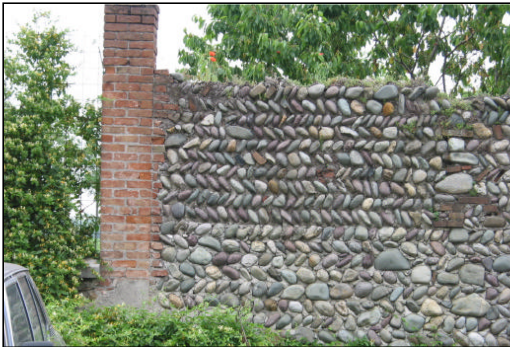
Foto 37 Muro di cinta
