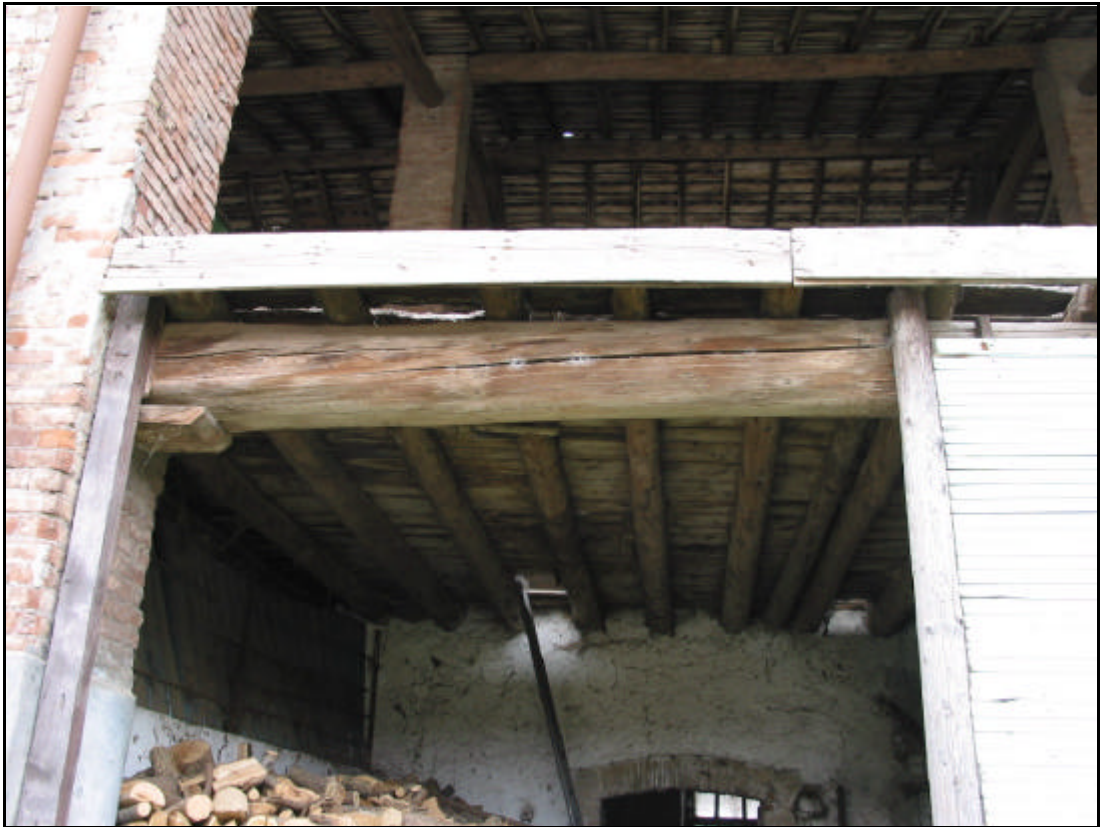
Foto 12 Solaio con buca del fieno
